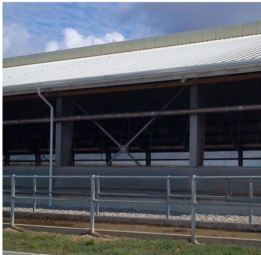
Obr. 7 a obr. 8 Prúdenie vzduchu zabezpečené sitovými záclonami, ktoré sú v prípade nevhodného počasia vytiahnuté nahor
