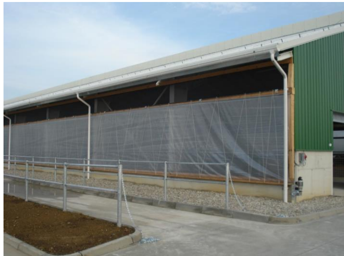
Obr. 7 a obr. 8 Prúdenie vzduchu zabezpečené sitovými záclonami, ktoré sú v prípade nevhodného počasia vytiahnuté nahor
