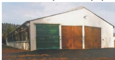
Prirodzené vetranie maštale s plachtovou reguláciou
