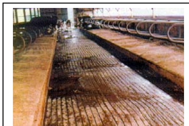
Obr. 8: Ryhovanie podlahy pre stabilitu zvierat
