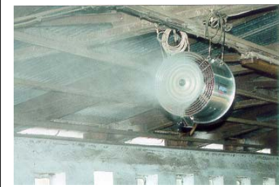
Ventilátor vybavený systémom rozprašovania vody
