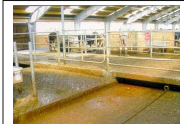
Obr. 7: Priečný zberný kanál v strede maštale
