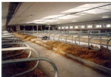
Obr. 105: Pre podstielanie a vyhrňovanie hnoja sú výhodnejšie prejazdné maštale
