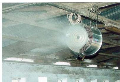
Obr. 76: Ochladzovanie maštale vodnou hmlou
