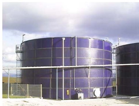
Obr. 7: Nadzemná skladovacia nádrž na hnojovicu
